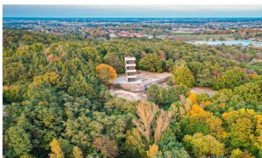
Budowa wieży z platformą widokową
