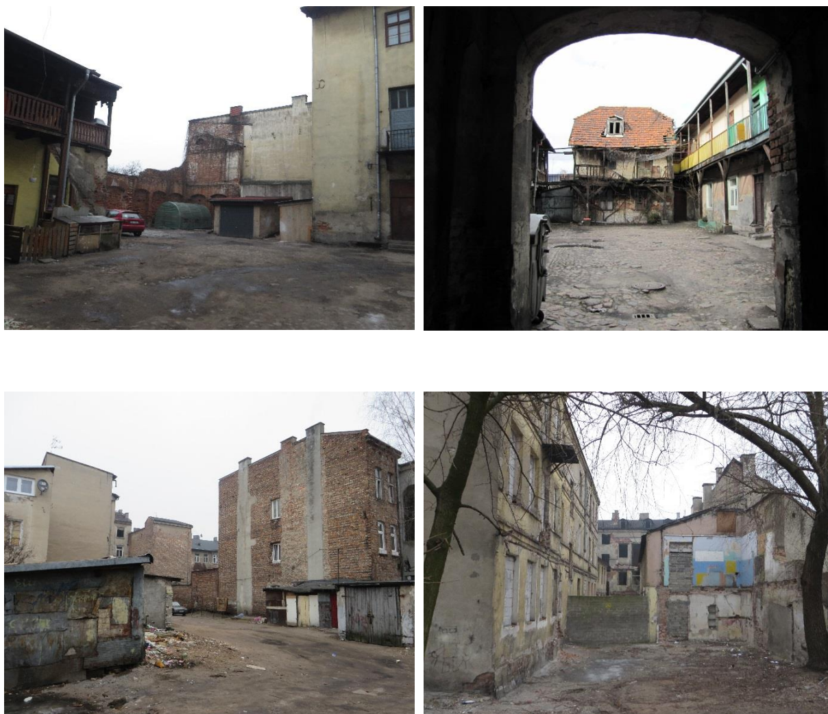
Fotografia 1. Budynki w obszarze rewitalizacji – przykłady, ul. 3 Maja (2016)
