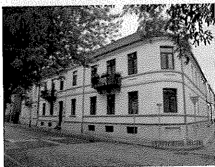
Fot. 7. Kamienica z oficyną Bulwary im. Marszałka J. Piłsudskiego 18.
