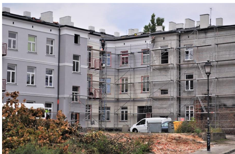
Fot. 16. Budynek przy ul. Brzeskiej 23 w trakcie remontu w ramach projektu pn. Dotacje do remontów (źródło Wydział Rewitalizacji UM Włocławek)
