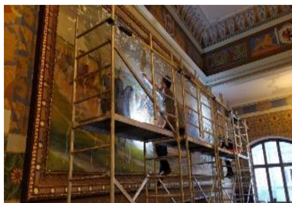
Fot. 6. Malowidło ścienne pn. „Wyjazd do pożaru” w trakcie prac konserwatorskich i restauratorskich w 2019 r. w ramach projektu pn.: Remont pomieszczenia „Sali Zebrań” oraz zabytkowego zegara w Klubie „Stara Remiza” (źródło: Wydział Rewitalizacji UM Włocławek)
